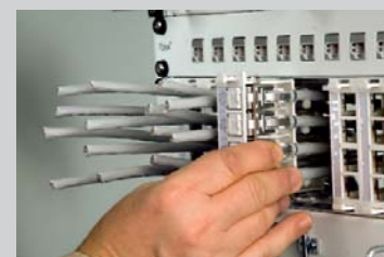
Encliquer les guide-fils dans les douilles, faire enclencher Keystone
