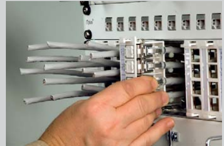
Encliquer les guide-fils dans les douilles, faire enclencher Keystone
