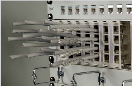
Préparer les câbles
