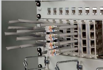
Câblage des guide-fils
