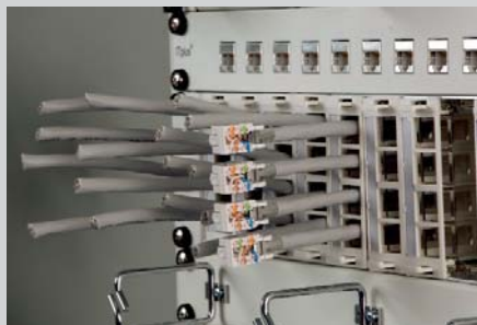
Câblage des guide-fils
